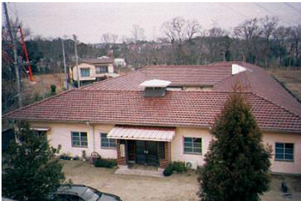
伝染病隔離病舎
