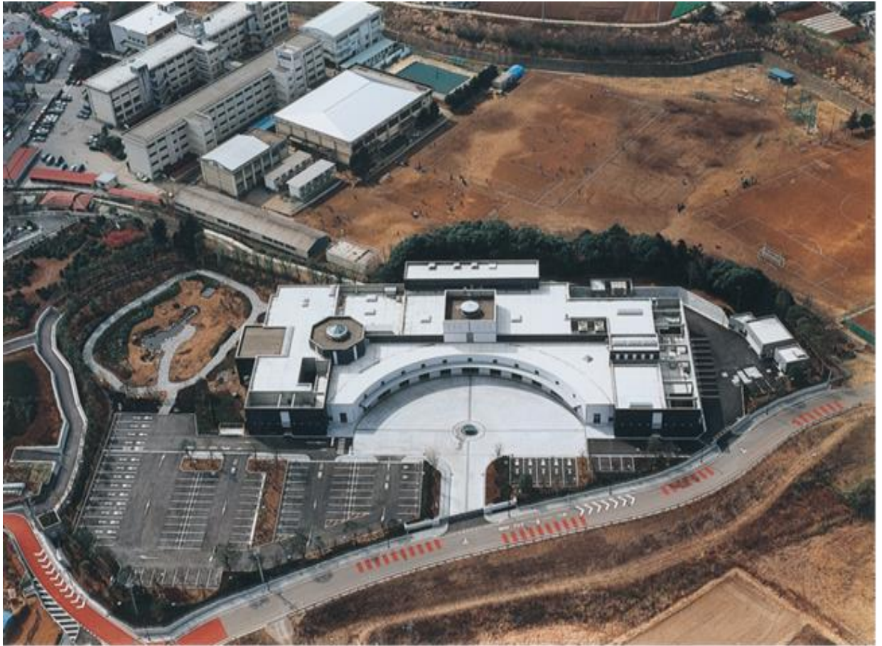
ウイングホール柏斎場全景
