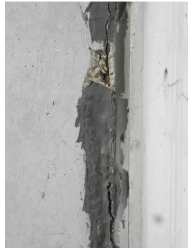
⑧ 式場側屋上コンクリート打放し壁に、鉄筋の錆によるコンクリートの爆裂がみられる。(写真 4-35、4-36)
