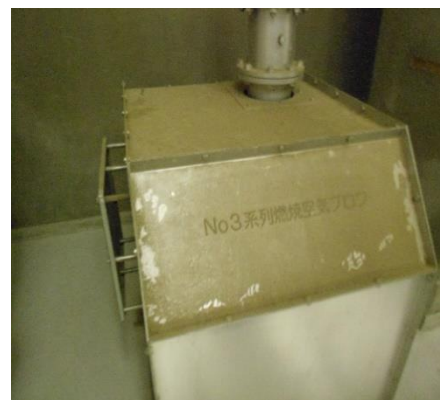
写真 4-58 燃焼用空気送風機
