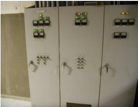
写真 4-63 動力制御盤
