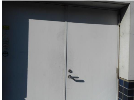
⑩ 外部廻り鋼製ドア全般に塗膜劣化（チョーキング）が見られる。（写真 4-39、4-40）
