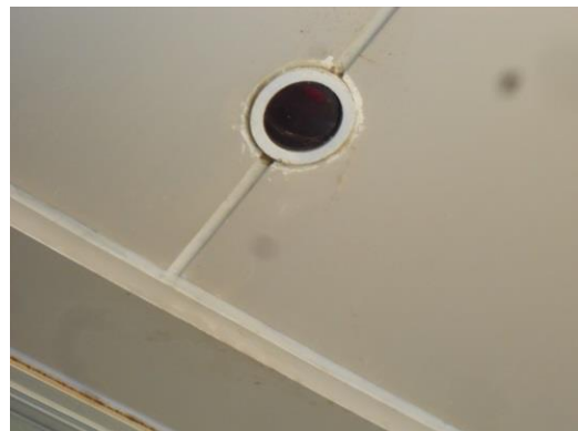
⑫ 1階正面庇とサッシ取合部に庇上面からの漏水による錆汁が発生している。ダウンライト取付部に漏水している。（写真 4-43、4-44）
