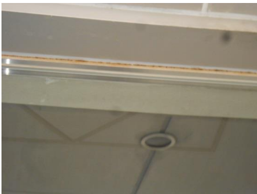
⑫ 1階正面庇とサッシ取合部に庇上面からの漏水による錆汁が発生している。ダウンライト取付部に漏水している。（写真 4-43、4-44）
