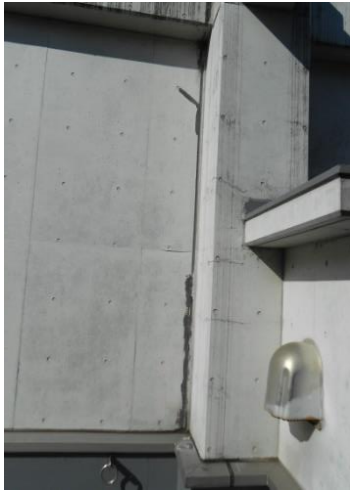
⑧ 式場側屋上コンクリート打放し壁に、鉄筋の錆によるコンクリートの爆裂がみられる。(写真 4-35、4-36)
