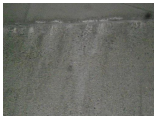
⑭ コロネード東出入口上部天井面に、上部屋上アルミ笠木廻りからの漏水が見られる。（写真 4-47、4-48）
