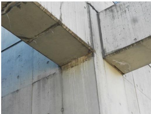
⑨ 式場側屋上打放し梁のクラック、錆汁が発生している。コンクリートの爆裂につながる。(写真 4-37、4-38)
