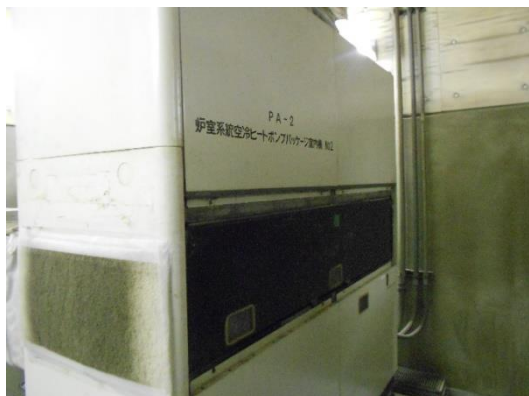
写真 4-49 ヒートポンプパッケージエアコン (錆の発生、フィルター目詰まり)
