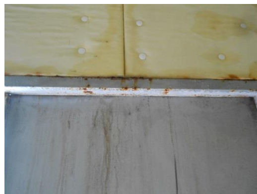
⑬ 付属棟（ブロー室）の天井及び壁面のグラスウールボードと躯体との間に結露が生じている。取付金物の腐食により錆が発生している。（写真 4-45、4-46）
