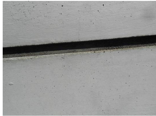
⑪ コンクリート打放し、柱型全般にシーリング材の劣化がみられる。雨水内部侵入によりコンクリートの劣化（中性化）が進む。（写真 4-41、4-42）
