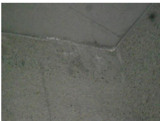
⑭ コロネード東出入口上部天井面に、上部屋上アルミ笠木廻りからの漏水が見られる。（写真 4-47、4-48）
