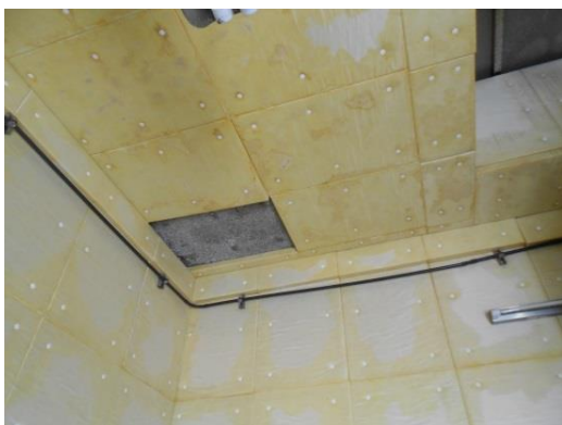
⑬ 付属棟（ブロー室）の天井及び壁面のグラスウールボードと躯体との間に結露が生じている。取付金物の腐食により錆が発生している。（写真 4-45、4-46）
