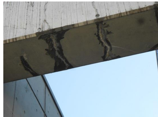
⑨ 式場側屋上打放し梁のクラック、錆汁が発生している。コンクリートの爆裂につながる。(写真 4-37、4-38)
