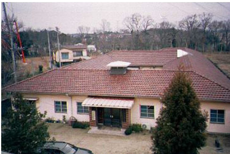
伝染病隔離病舎
